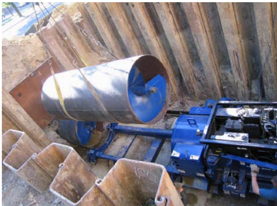
Установка шнекового бурения American Augers 48-900, Санкт-Петербург
