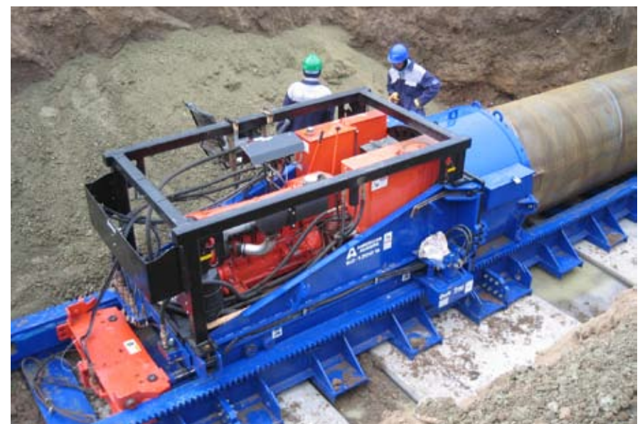
Установка шнекового бурения American Augers 60-1200 , Алжир
