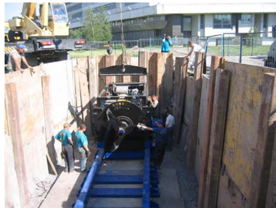
Установка шнекового бурения American Augers 72-1200 , Санкт-Петербург, установка машины в котловане
